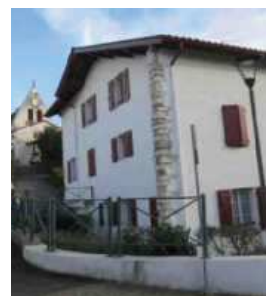
L'ancien presbytère accueille plusieurs logements sociaux. PHOTO F.G.
